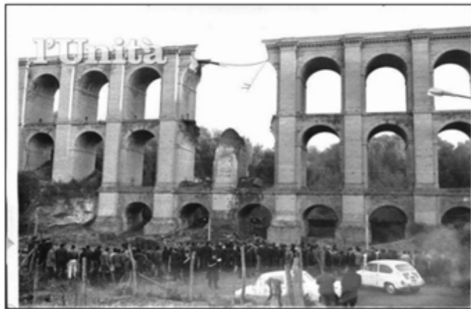
Figura 9.42: Crollo ponte Ariccia
