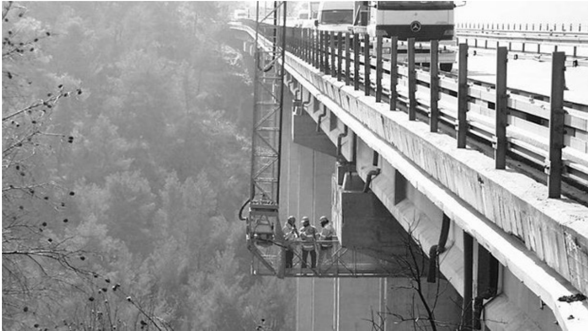
Figura 3.8: Esempio di ispezione effettuata con Bybridge
