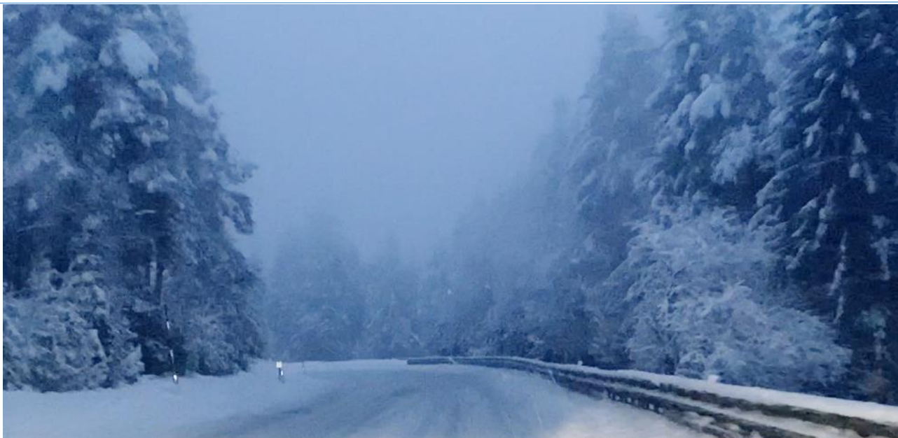
Figura 18 – caratterizzazione infrastruttura stradale
