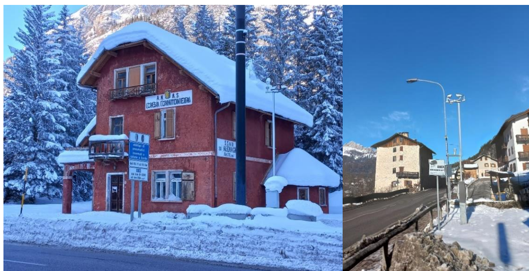
Figura 6- Centraline meteo installate lungo la SS 51 "di Alemagna"
